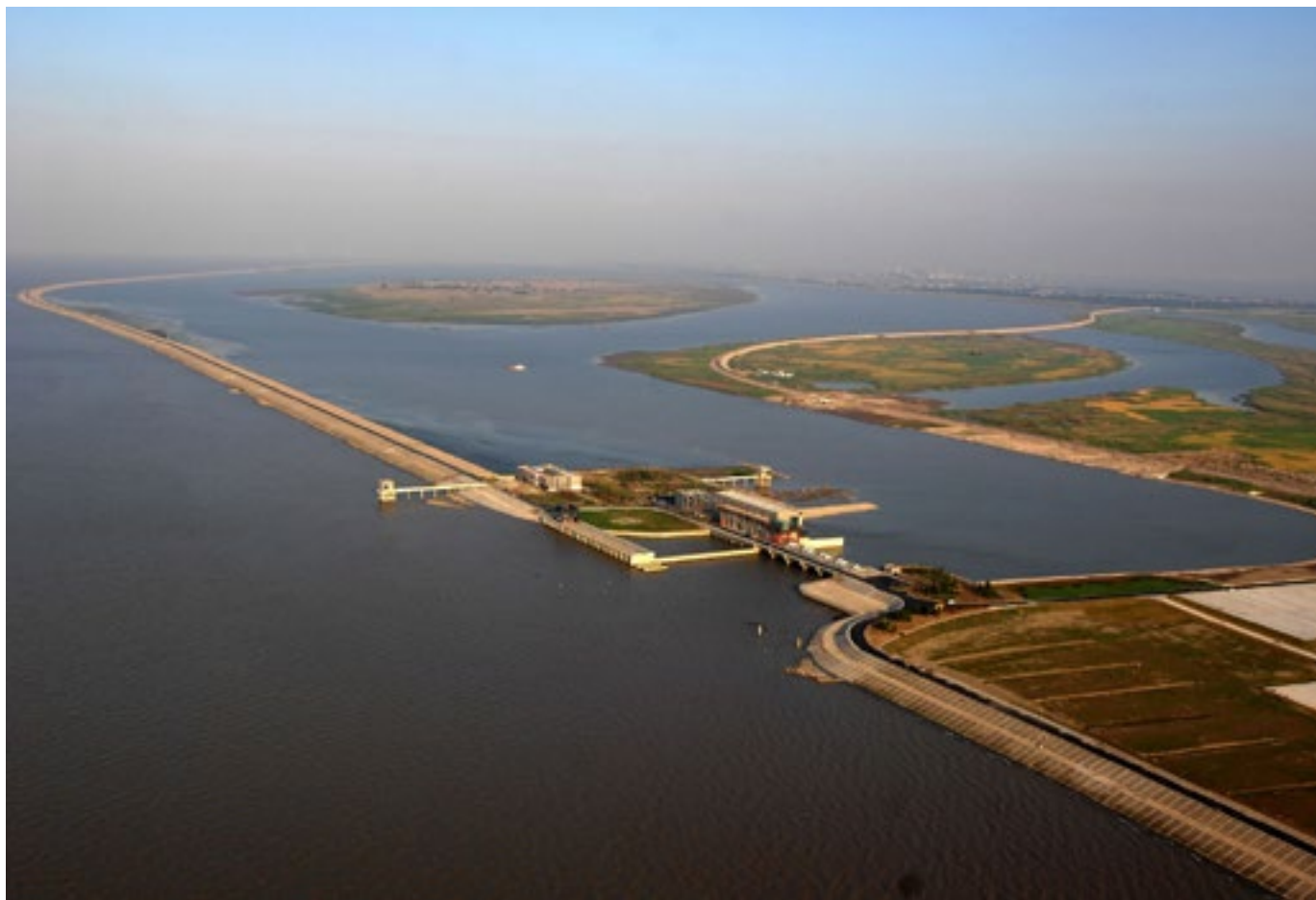
上海市长江口青草沙水源取水工程
